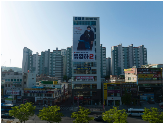
태운빌딩 준공사진 촬영
